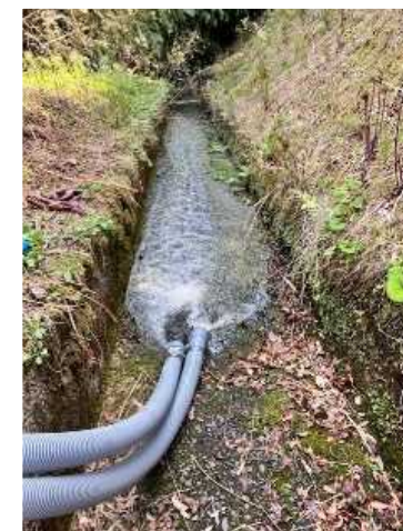
ため池の水位低下作業（排水用サイホン装置の設置）
