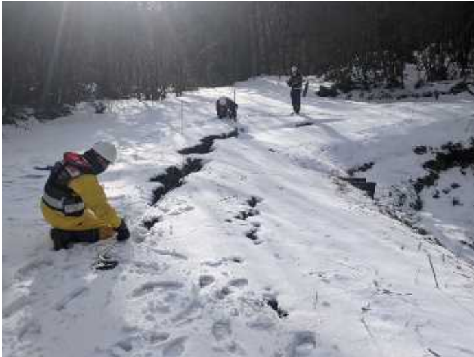
ため池堤体の亀裂等の変状及び洪水吐等の損傷確認
