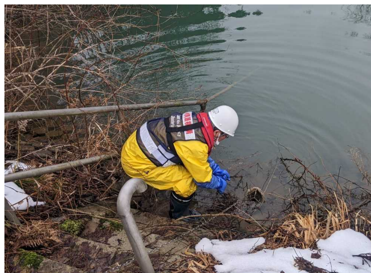
ため池の水位低下作業（斜樋の開栓）
