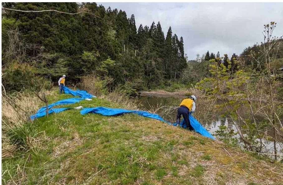
被災箇所保護（ブルーシート設置）
