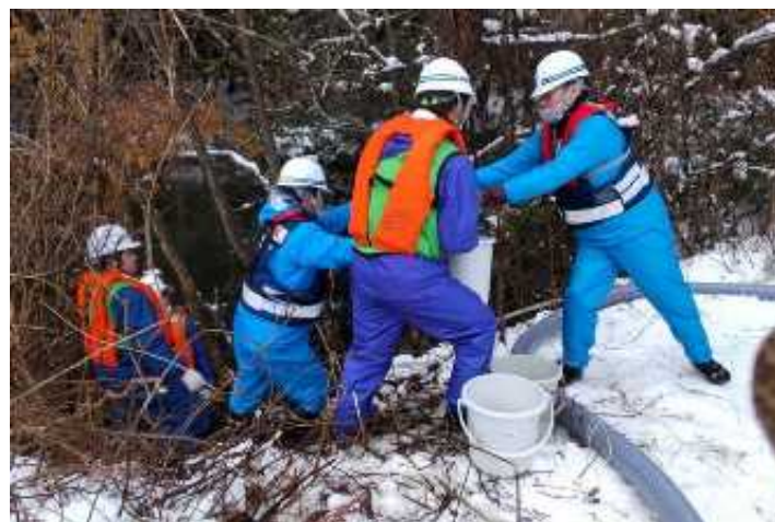
ため池の水位低下作業（排水用サイホン装置の設置）
